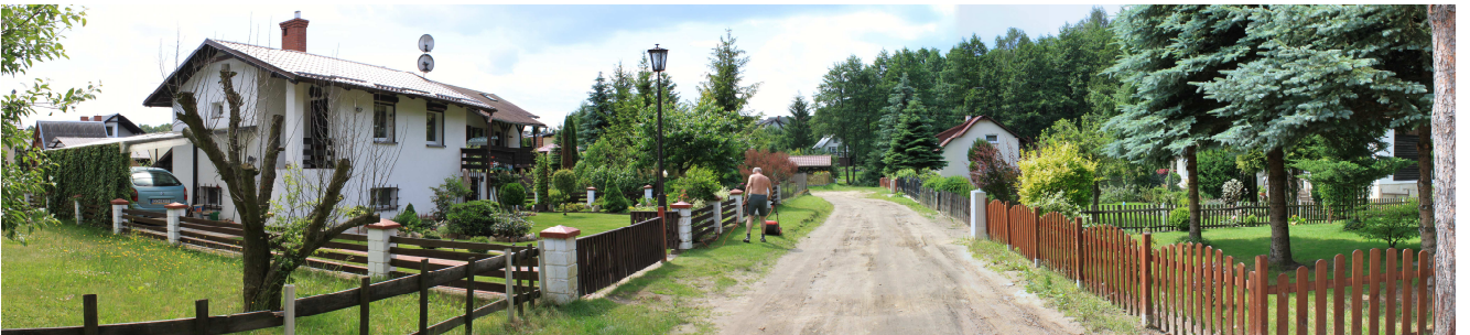
Fot. 3 Zabudowa na terenie ROD „Zacisze” – widok na zachodnią część terenu w kierunku południowym.
