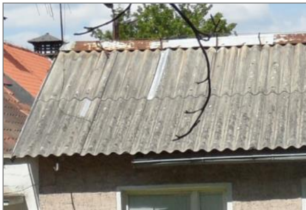
Fot. 1 Płyty azbestowo-cementowe faliste
