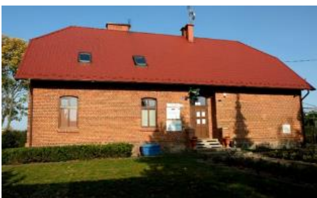
Zdjęcie 38 – Budynek świetlicy wiejskiej w Kruszcze
