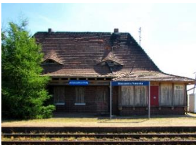
Zdjęcie 11 – Moszczenica przystanek kolejowy
