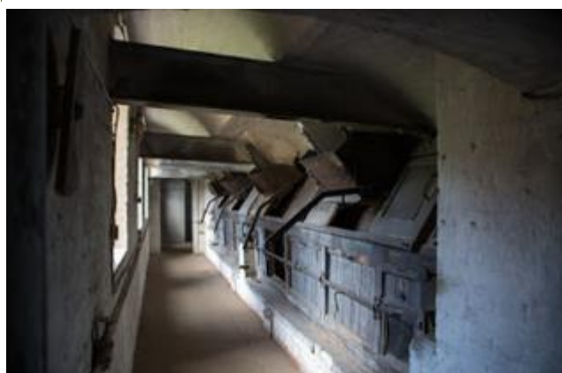
Zdjęcie 5 – Wyłuszczeniarnia nasion wewnątrz
