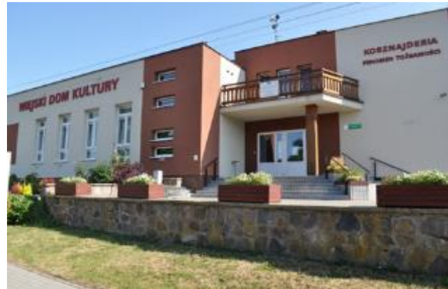
Zdjęcie 21 – Budynek Domu Kultury w Silnie
