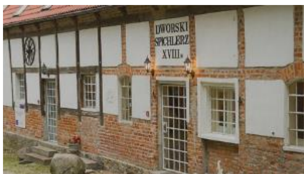
Zdjęcie 35 – Czartolomie, budynek dawnego spichlerza
