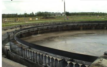
Miejska oczyszczalnia ścieków
