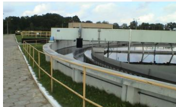
Miejska oczyszczalnia ścieków "Igiy"
